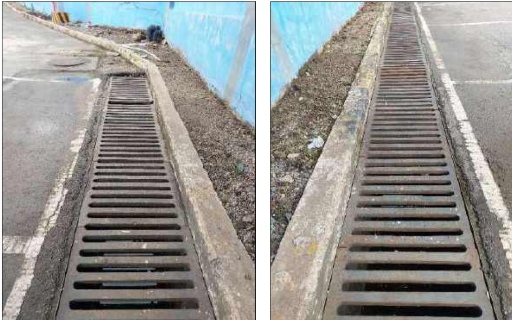
Hình 3.2. Hệ thống thu gom, thoát nước mưa hiện hữu tại cơ sở
