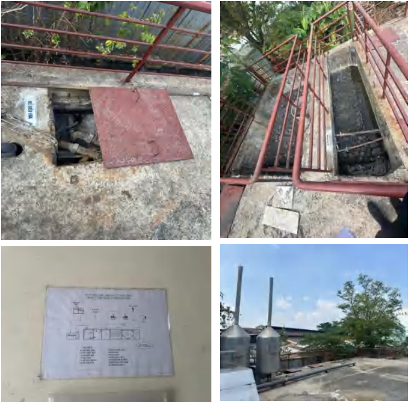
Hình 3.7 Hạng mục bể của hệ thống xử lý nước thải
