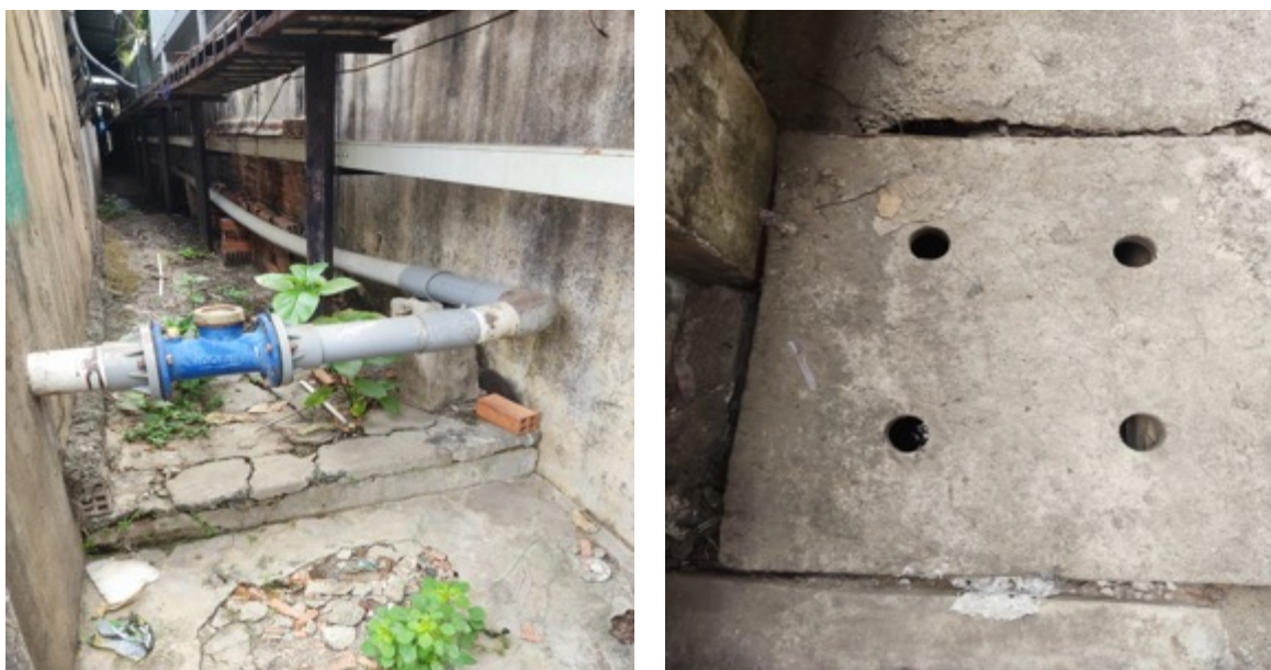
Hình ảnh đường ống thoát nước thải sau xử lý và hố ga thoát nước bên trong cơ sở
