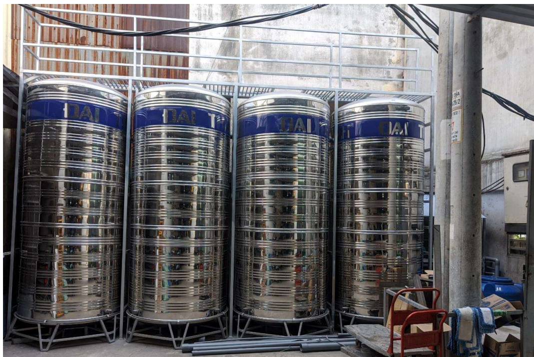
Hình 3.4. Khu vực hệ thống xử lý nước thải
