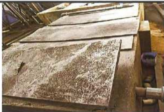
Hình 3.20. Hình ảnh công trình HTXL nước thải hiện nay của Cơ sở
